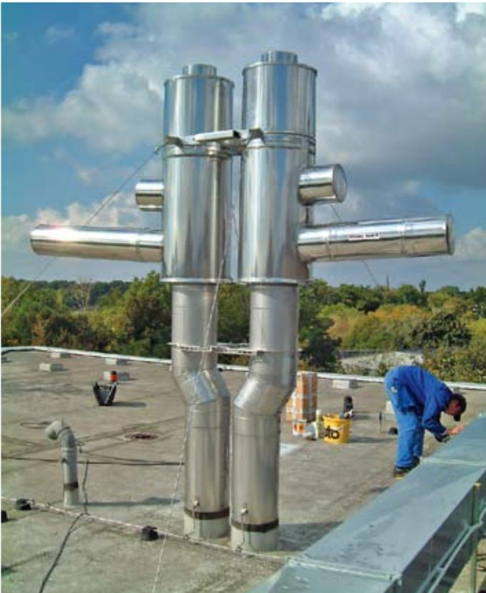
■ Bild 7: Reaktiv Resonatoren sitzen hier an den Mündungsschalldämpfern - nur eine der möglichen Sonderlösungen.
