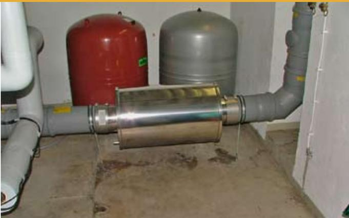
■ Bild 4: Hier wurde ein Tiefton-Schalldämpfer in eine Abgasanlage aus Kunststoff installiert.
