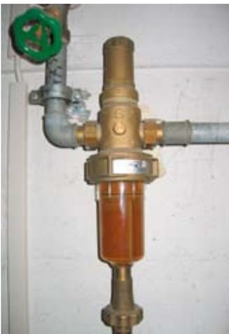
■ Bild 2: Verschmutzter, nicht gewarteter Hauswasserfilter.
