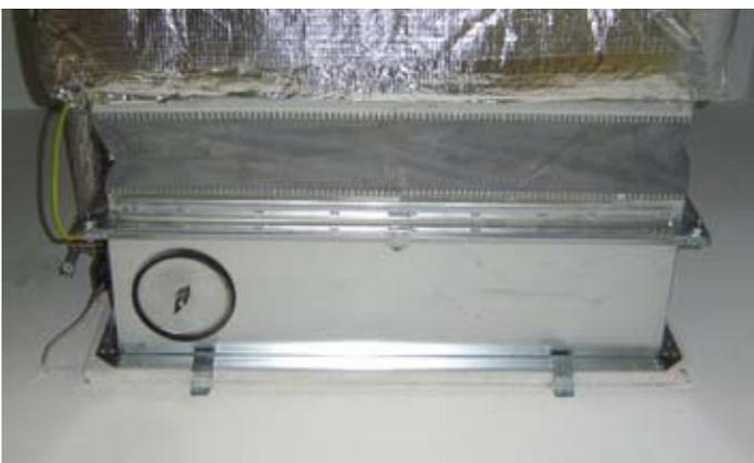
■ Einbau der „FK-90“ in eine leichte Trennwand mit Einbaurahmen. Der elastische Stützen muss gemäß Zulassung im gestreckten Zustand montiert werden, um die Dehnung im Brandfall aufnehmen zu können.
