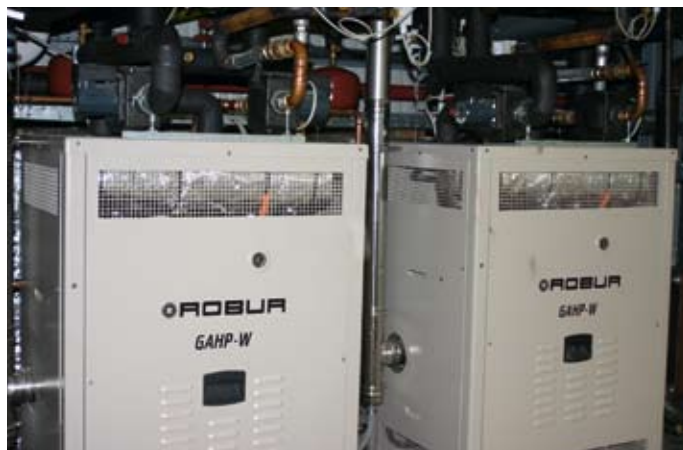
■ Bild 5: Praxiseinsatz einer Absorptionswärmepumpenanlage zum Heizen (jeweils 35 kW) und Kühlen (jeweils 17,5 kW) eines Bürogebäudes. Bild: Isocal
